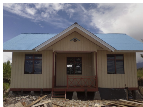
Bijgebouw in aanbouw
